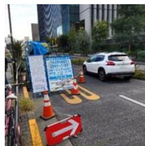
写真-5 作業帯の設置状況
