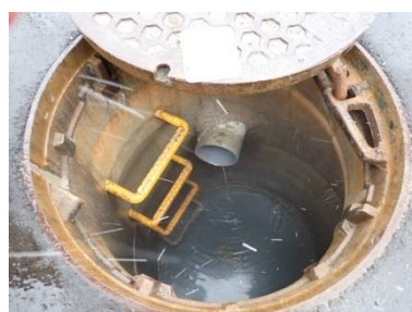
写真-5 金沢市 管きよ閉塞に伴う道路側溝利用の地上仮配管による圧送
