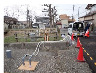
写真-5 金沢市 管きよ閉塞に伴う道路側溝利用の地上仮配管による圧送
