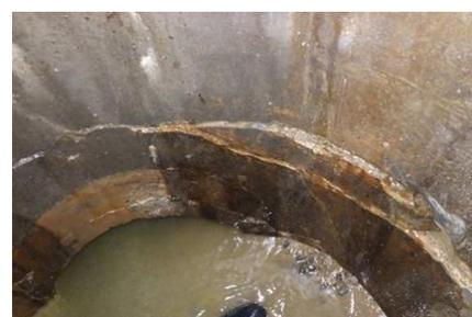
写真-5 消散弁を貫通しているマンホール躯体下部の水平断裂
