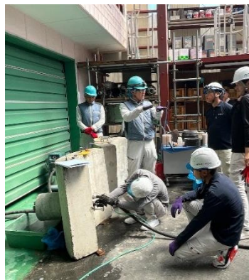
写真-9 耐震一発くん 研修会実施状況
